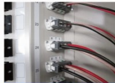
3極をワンプッシュ接続 コネクタ接続部は二重ロックで誤抜防止 コネクタは識別マークと逆差し防止構造
