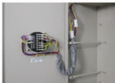
プラグイン式ブレーカの採用 ブレーカレバーに誤操作防止カバー
